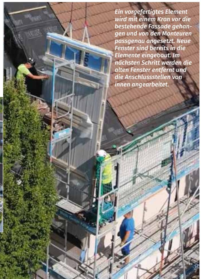
Ein vorgefertigtes Element wird mit einem Kran vor die bestehende Fassade gehangen und von den Monteuren passgenau angesetzt. Neue Fenster sind bereits in die Elemente eingebaut. Im nächsten Schritt werden die alten Fenster entfernt und die Anschlussstellen von innen angearbeitet.
