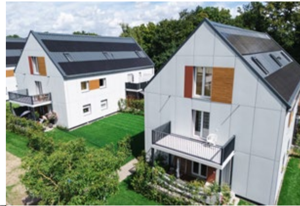
Sanierte Gebäude Ganghoferstraße
