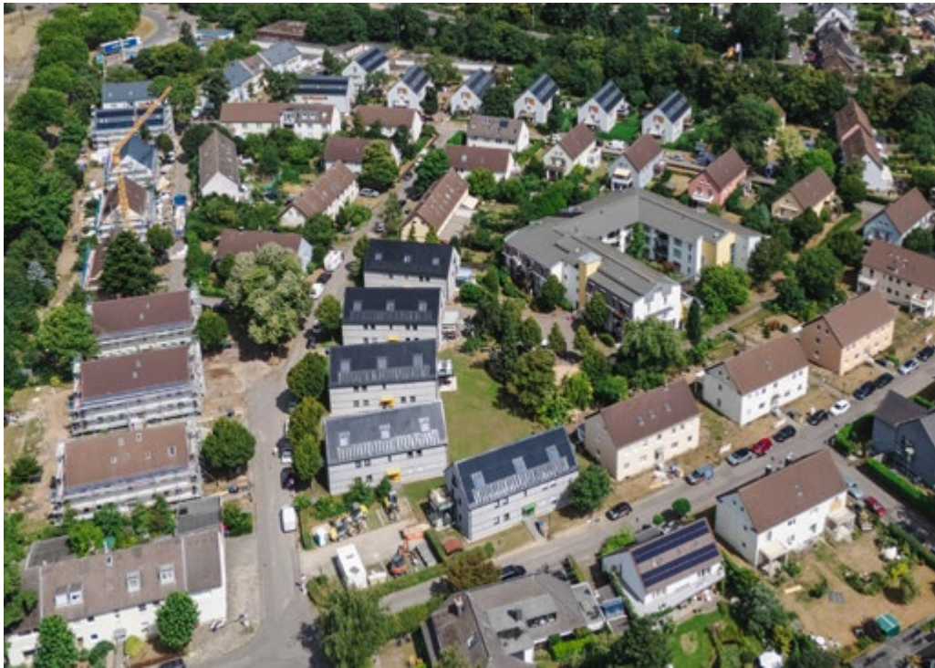
Sanierungsprojekt Löns-Siedlung Stockum
