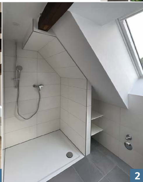
1 und 2: Dachausbau in Stockum 3: Irmgard-/Margaretenstraße in Grafenberg 4: Rolandstraße in Derendorf 5: Fritz-von-Wille-Straße in Rath
